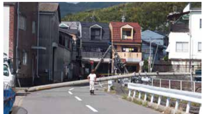
昨年の台風で電柱が倒れ、通行不可に。 (物集女街道近く)
