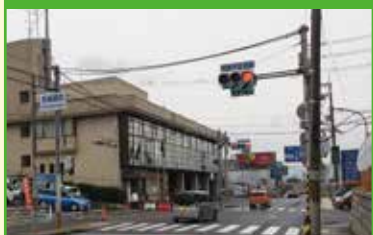
矢印信号機設置 (向日町競輪場前)
