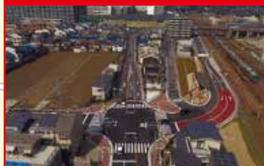
上久世岩見上里線 (修理工式交差点)
